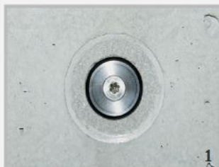
Bündiger Verschluss bei Mauerstärken mit Dichtlippe.
