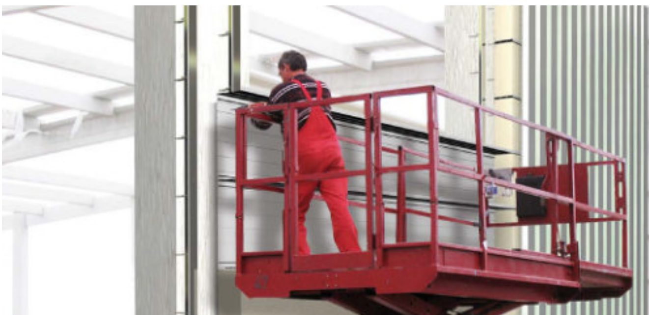
Montage einer mehrlagigen isolierten Trapezblech-Wand.
