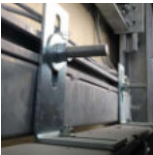
Befestigung von Aufzugstüren in einem Gitterträgerschacht
