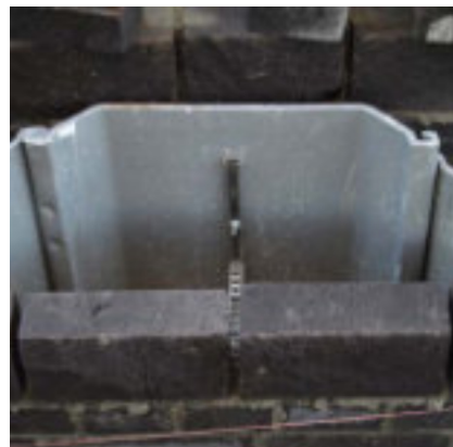
Anschluss von Verblendmauerwerk an Spundwand
